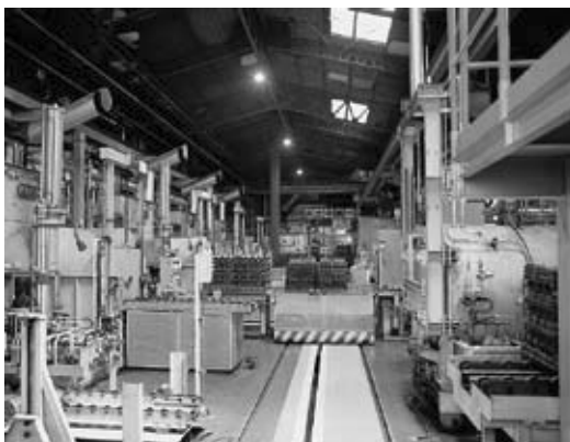
昼夜稼働する熱処理設備
